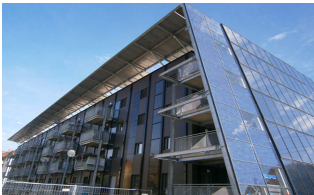
Abbildung 59: Aktive Gebäudeoberflächen in Dach und Fassade (150 m 2 Bruttokollektorfläche) in diesem Pilotprojekt als integraler Bestandteil einer Generalsanierung eines Geschloßwohngebäudes aus den 60er Jahren zum Plusenergiegebäude (Bildquelle: AEE INTEC)
