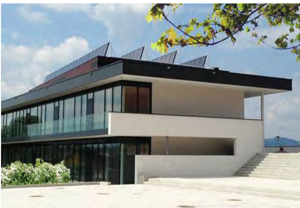
Abbildung 22: Gebäudeansicht der nahezu 100% solarthermischen Wärmeversorgung für das rund 1.500m 2 große Veranstaltungszentrum Hallwang, Sbg. (links, Bildquelle: Gemeinde Hallwang). Rechts dargestellt ist die Verrohrung für die Aktivierung der Bauteilmassen (Bildquelle: Harald Kuster)
