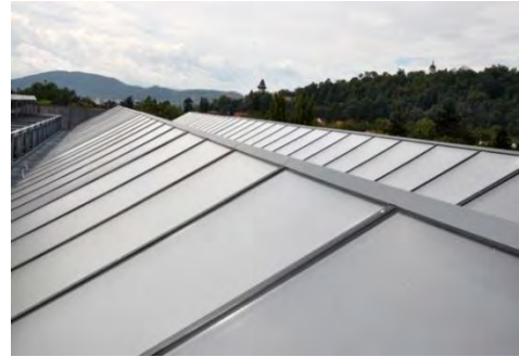
Abbildung 24: Solarthermisches Heizen, Warmwasserbereiten und Kühlen (105 kW Absorptionskältemaschine) am Chemiegebäude und der Mensa der Karl Franzens Universität in Graz in Verbindung mit einer 632 m 2 großen Kollektorfläche 7 m 3 Speichervolumen (Bildquelle: http://on.uni-graz.at )
