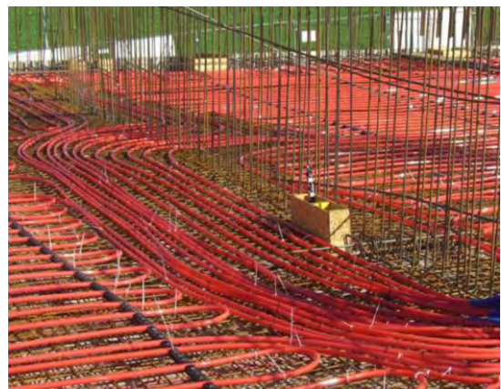
Abbildung 22: Gebäudeansicht der nahezu 100% solarthermischen Wärmeversorgung für das rund 1.500m 2 große Veranstaltungszentrum Hallwang, Sbg. (links, Bildquelle: Gemeinde Hallwang). Rechts dargestellt ist die Verrohrung für die Aktivierung der Bauteilmassen (Bildquelle: Harald Kuster)
