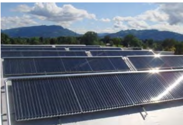
Abbildung 23: Über 70% solare Deckung für solarthermisches Heizen und Kühlen eines neuen, 5.000m 2 großen Betriebsgebäudes des Pumpenproduzenten KRAL, Vrlbg. (Bildquelle: Ritter XL Solar)
