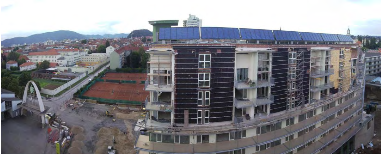
Abbildung 19: Errichtung einer thermischen Solaranlage mit 700 m 2 Bruttokollektorfläche und 75 m 3 Speichervolumen im Zuge der Neuerrichtung eines Geschosswohngebäudes mit 150 Wohneinheiten am Grazer Messequartier (Bildquelle: S.O.L.I.D.)
