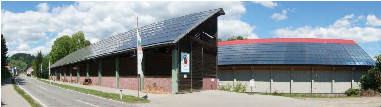
Abbildung 21: Ansicht der insgesamt 2.450 m 2 Kollektorfläche, die in das Biomasse-Nahwärmenetz Eibiswald, Stmk., mit einer maximalen Netzanschlussleistung von 4 MW einspeisen und damit die Sommerlast zwischen 80 und 90% abdecken (Bildquelle: AEE INTEC)
