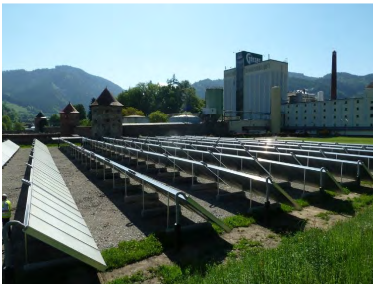
Abbildung 25: Darstellung der 1.500 m 2 Kollektorfläche (links) und des 200 m 3 fassenden Speichers (rechts) für eine solarthermische Unterstützung des Maischeprozesses (ca. 25% solare Deckung im Jahr) in der Brauerei Göss, Stmk. (Bildquelle: AEE INTEC)
