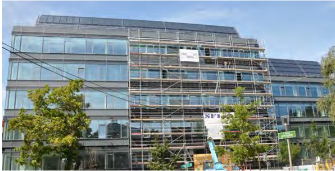
Abbildung 24: Solarthermisches Heizen, Warmwasserbereiten und Kühlen (105 kW Absorptionskältemaschine) am Chemiegebäude und der Mensa der Karl Franzens Universität in Graz in Verbindung mit einer 632 m 2 großen Kollektorfläche 7 m 3 Speichervolumen (Bildquelle: http://on.uni-graz.at )
