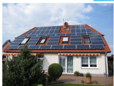
Einbindung dezentraler Erzeugung und Einspeisung mit Sicam 230
