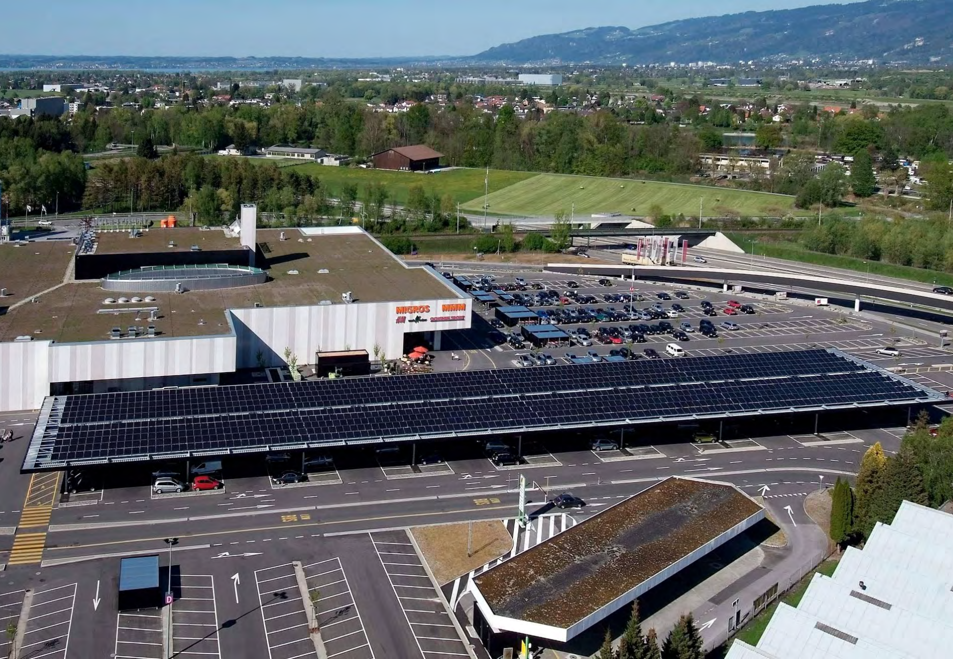
St.Gallisch-Appenzellischen Kraftwerke AG (SAK), EKZ Rheinpark St. Margrethen
