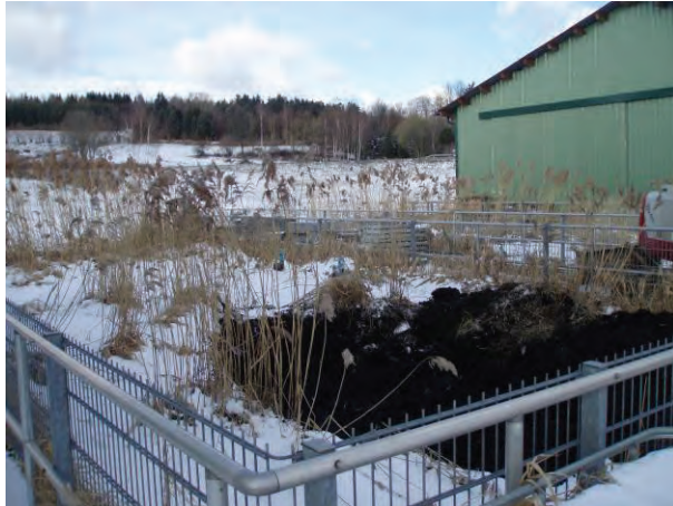
Abbildung 62: Schlammbecken der Kläranlage Großschönau
