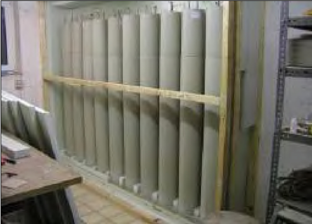
Abb. 11: LWS-System Fa. Powertank GmbH (Einzelzellen)
