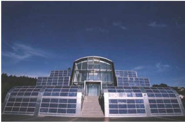
Foto: Gutau, OÖ, KW-Solartechnik
