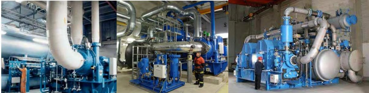
Abbildung 3: Großwärmepumpen in den Fernwärmesystemen von Stockholm (links), Helsinki (Mitte) und Oslo (Bildquelle: Friotherm)
