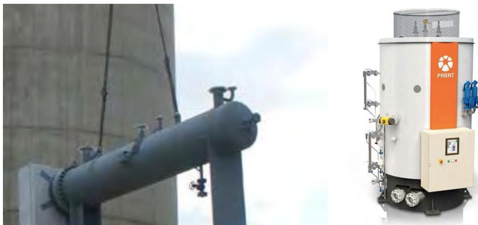
Abbildung 2: Power-To-Heat Umwandler nach dem Prinzip der Widerstandsheizung (links) und des Elektrodenheizkessels (rechts) (Bildquellen: Stadtwerke Schwerin, Parat)
