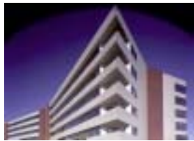
Endverbrauchttechnologien in Industrie und Gebäude, CHP
