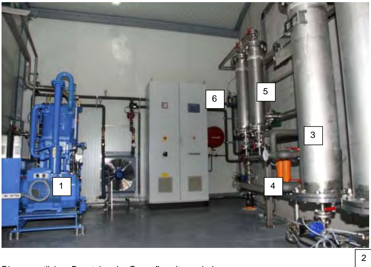
Foto 7 Die Gasaufbereitung (Quelle: AGRAR PLUS)
