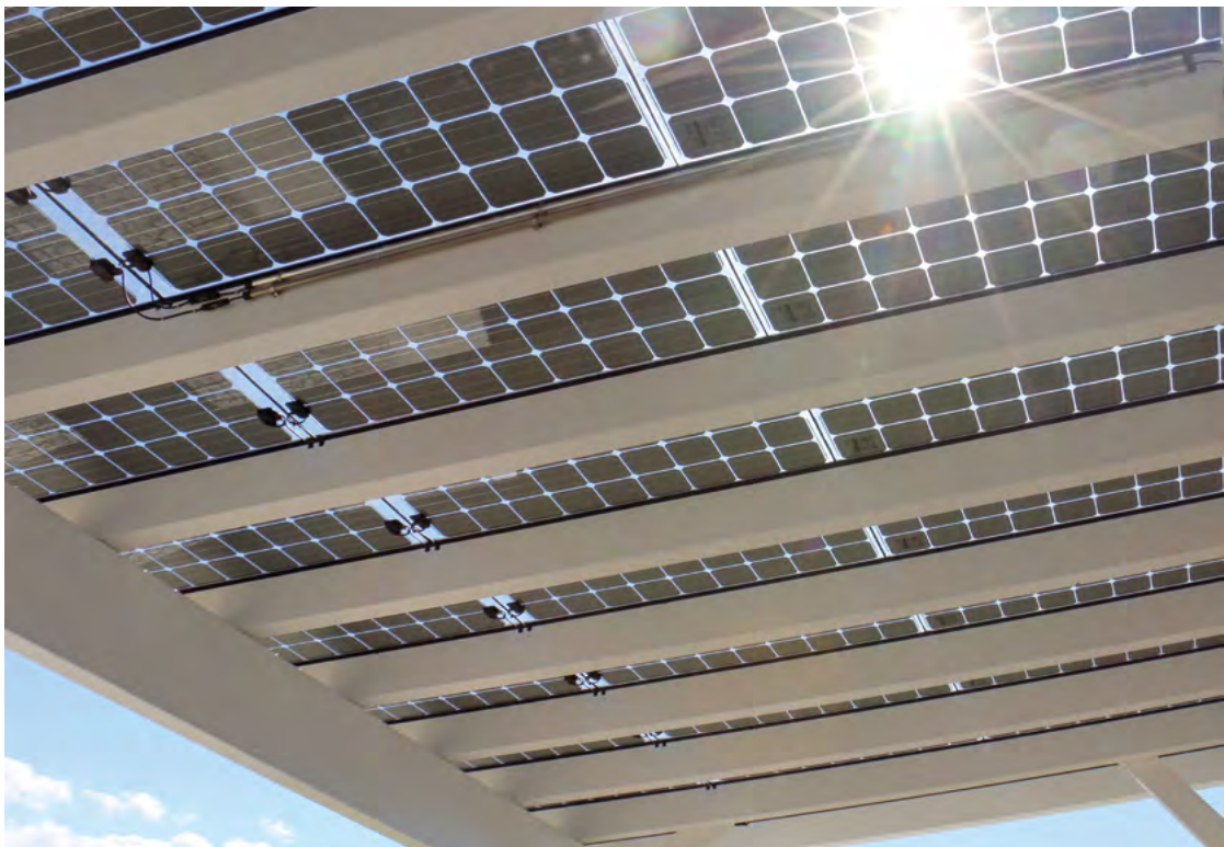
Abb. 8–9: Carport mit integrierten PV Modulen spendet Schatten und produziert Strom.
