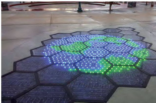
Abb. 4–7: Prototypische Solarstraßen-Elemente aktuell laufender Projekte.
