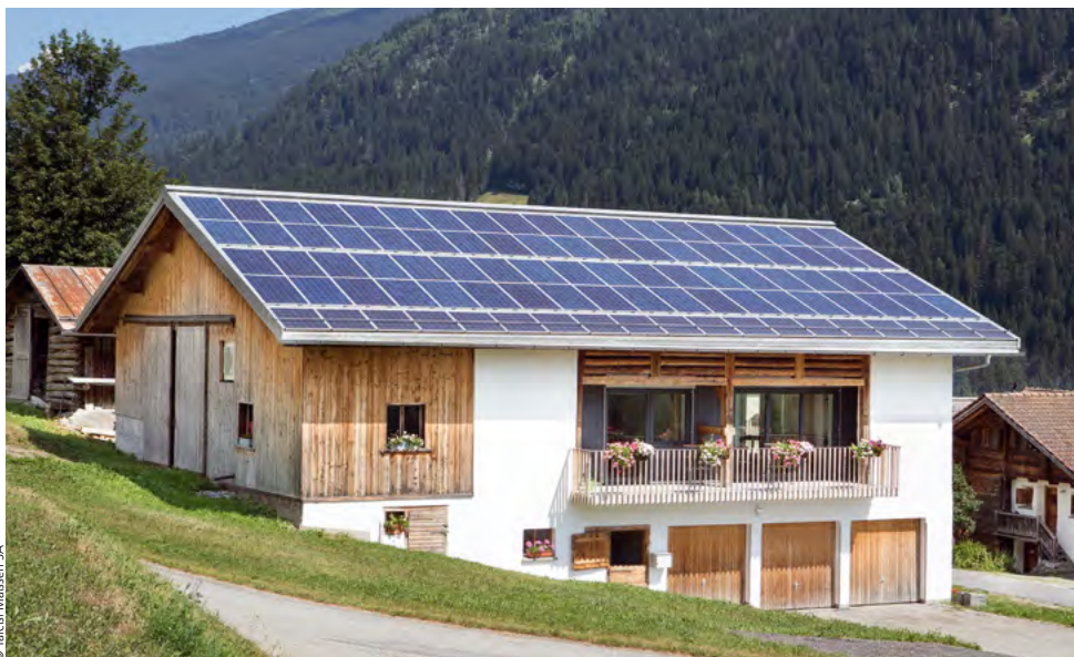
Abb. 16: Beispiel einer voll integrierten Photovoltaikanlage auf einem landwirtschaftlichen Nutz-/Wohngebäude in der Schweiz 10 .
