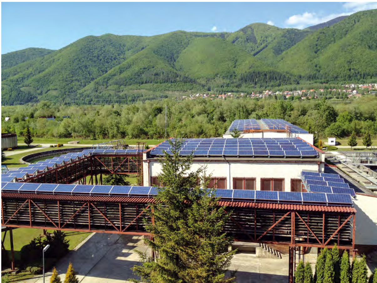
Abb. 2: Volles Ausnutzen der Betriebsdachflächen für eine Photovoltaikanlage.
