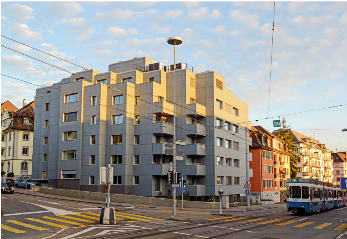
Abb. 26: Gebäude von Viriden-Architekten in Zürich: Photovoltaik goes Mimikri: Graue Solarmodule made in Austria sind nicht mehr von herkömmlichen Fassadenelementen zu unterscheiden. BIPV-Fassaden ermöglichen den Plusenergie-Standard.
